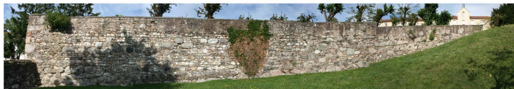
mur de terrasse de l'hôpital de Fourvière
