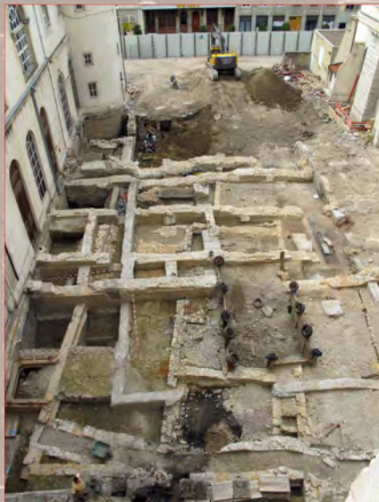
Fouille de la cour de la Chauffage (2012-2013)
