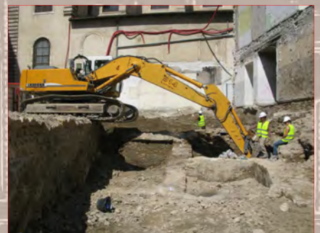
Fouille au sud de la chapelle rue Bellecordière (2015)
