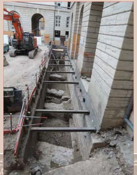
Fouille en tranchée blindée dans la cour Saint-Henri (2016)
