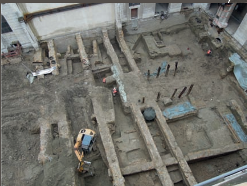
Dégagement jusqu'au terrain naturel des structures en place cour de la Chaufferie Unearthing up to the natural land level of the structures in place in the cour de la Chaufferie
