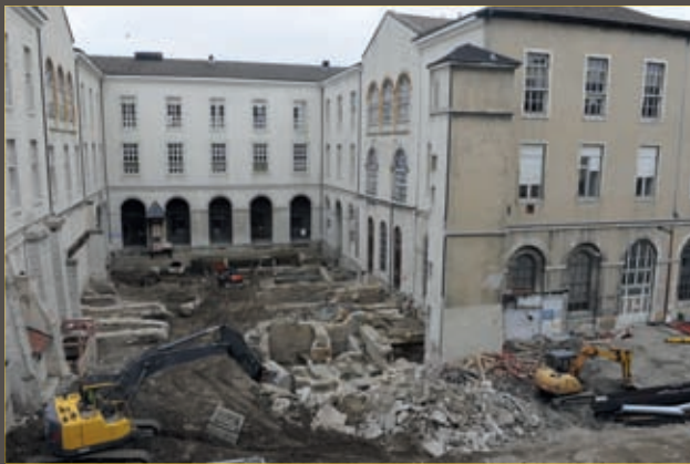
Vue générale de la fouille de la cour de la Chaufferie © Muriel Chaulet / Ville de Lyon General view of the excavation of the cour de la Chaufferie
