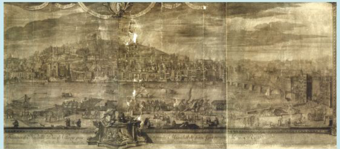
Le quai Saint-Antoine entre le port du Temple et le pont de Pierre. Vue de F. Cléric, 1719-1720. © Collection Bibliothèque municipale de Lyon Coste 259.
