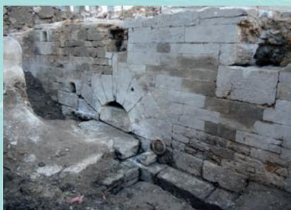
L'emmarchement du quai Villeroy permettait aux bateaux un amarrage aisé. Un imposant système de pilotis permettait de soutenir la construction
