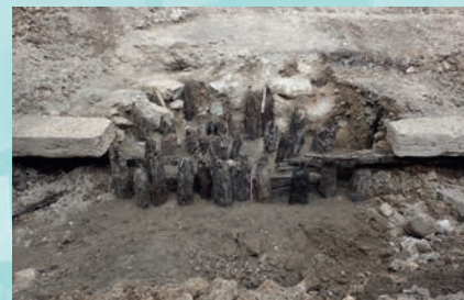
Pieux de fondation du quai Saint-Antoine
