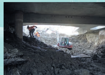
Fouille sous dalle (avril 2018)
