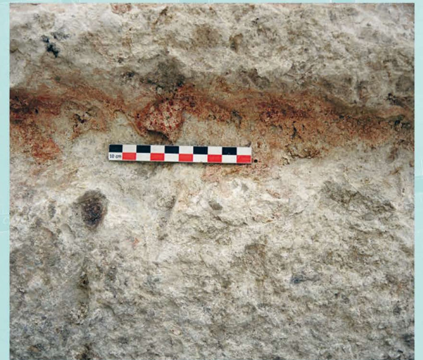
Traces de mortier de tuileau dans la gorge d'un bloc.
