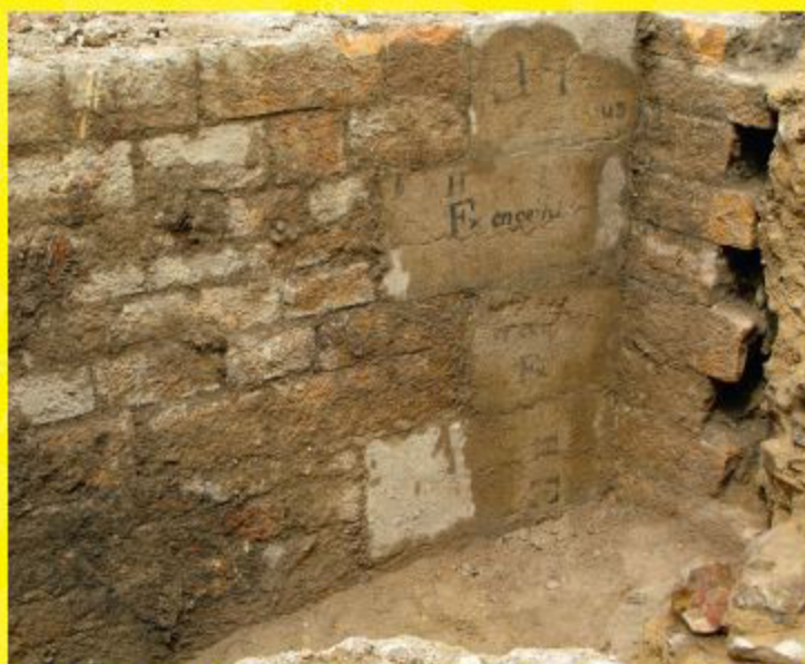
Graffiti d'un chaînage d'angle
