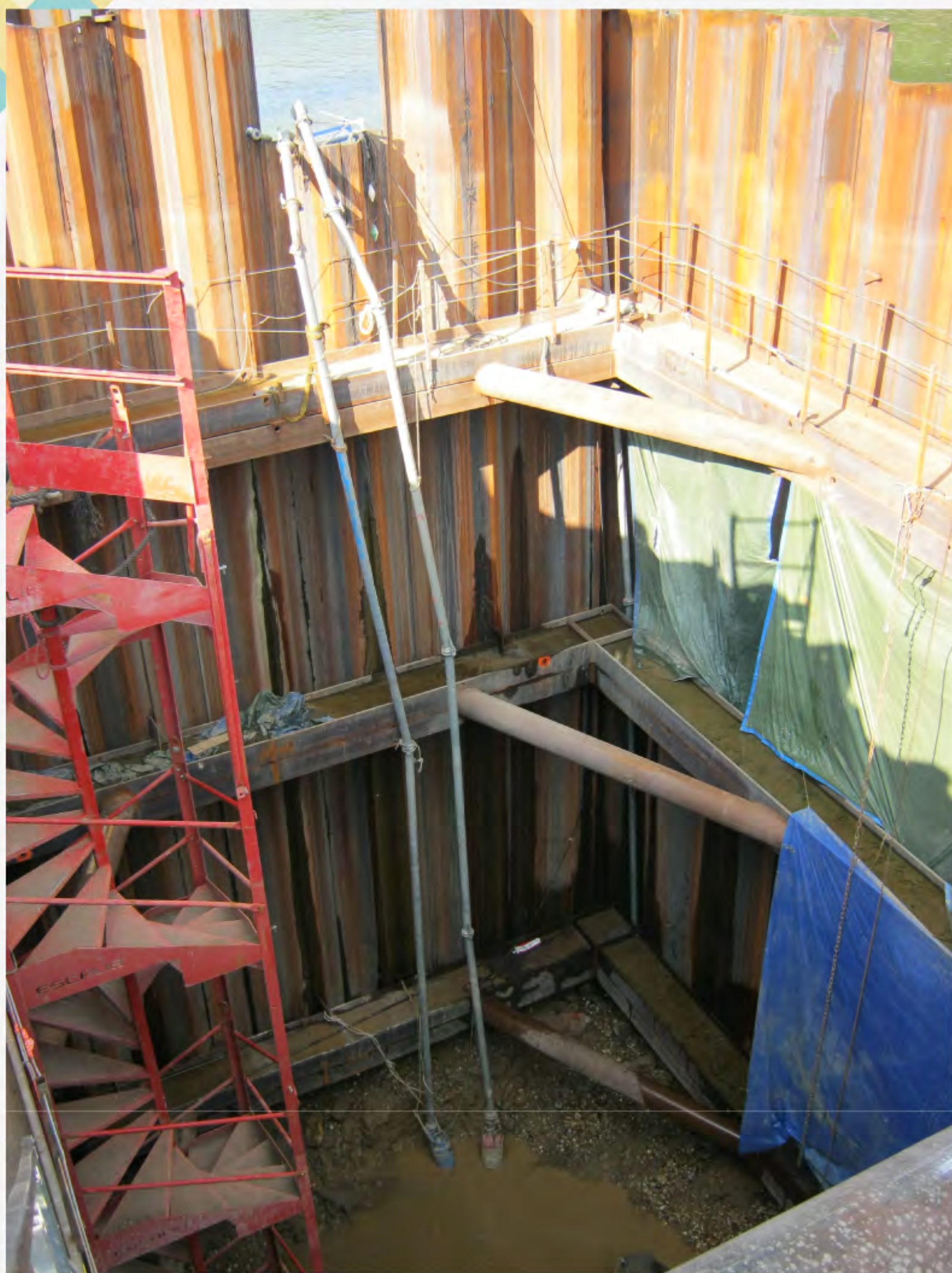
vue intérieure du batardeau
