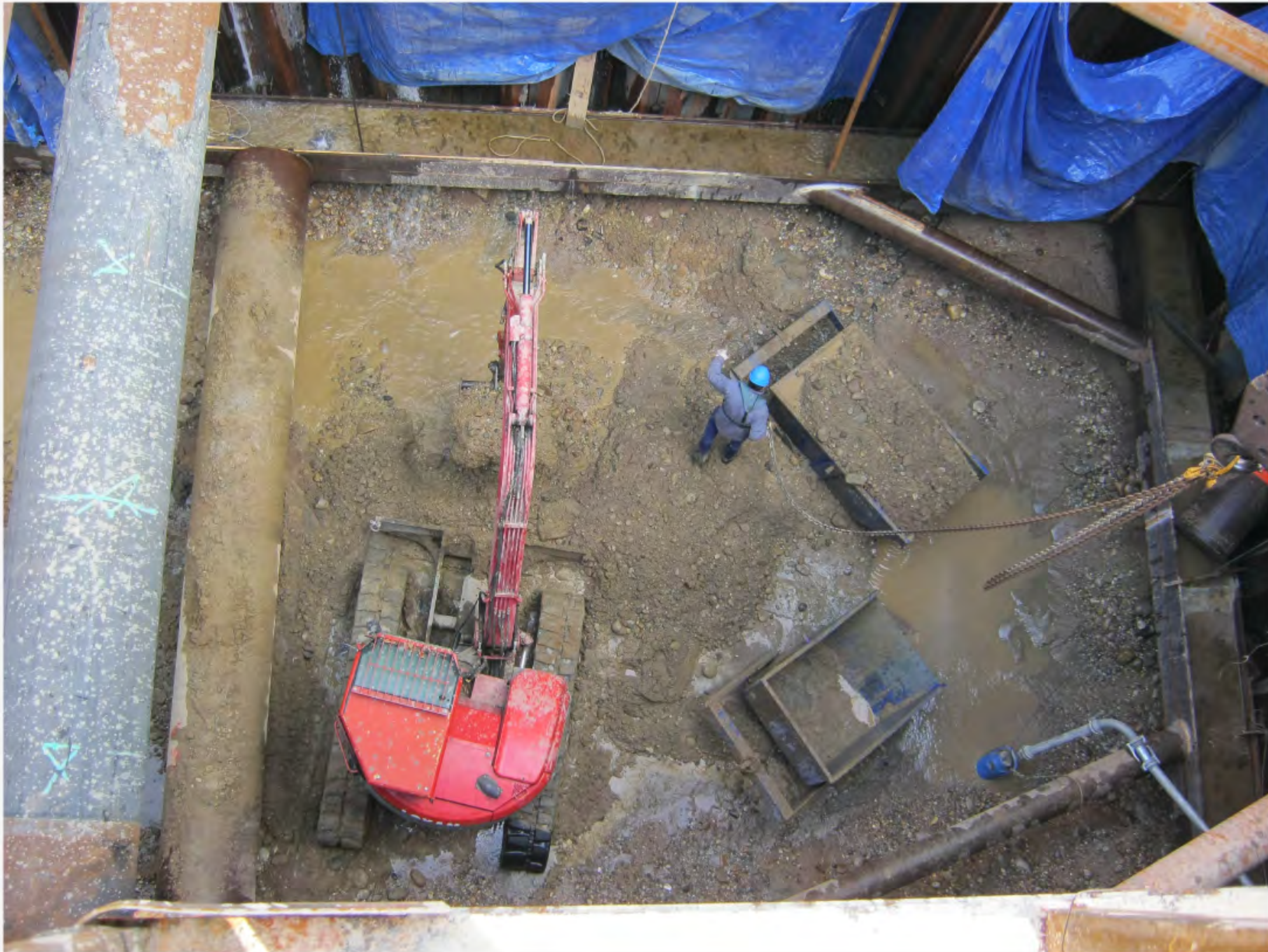
intérieur du batardeau : décapage à la pelle mécanique
