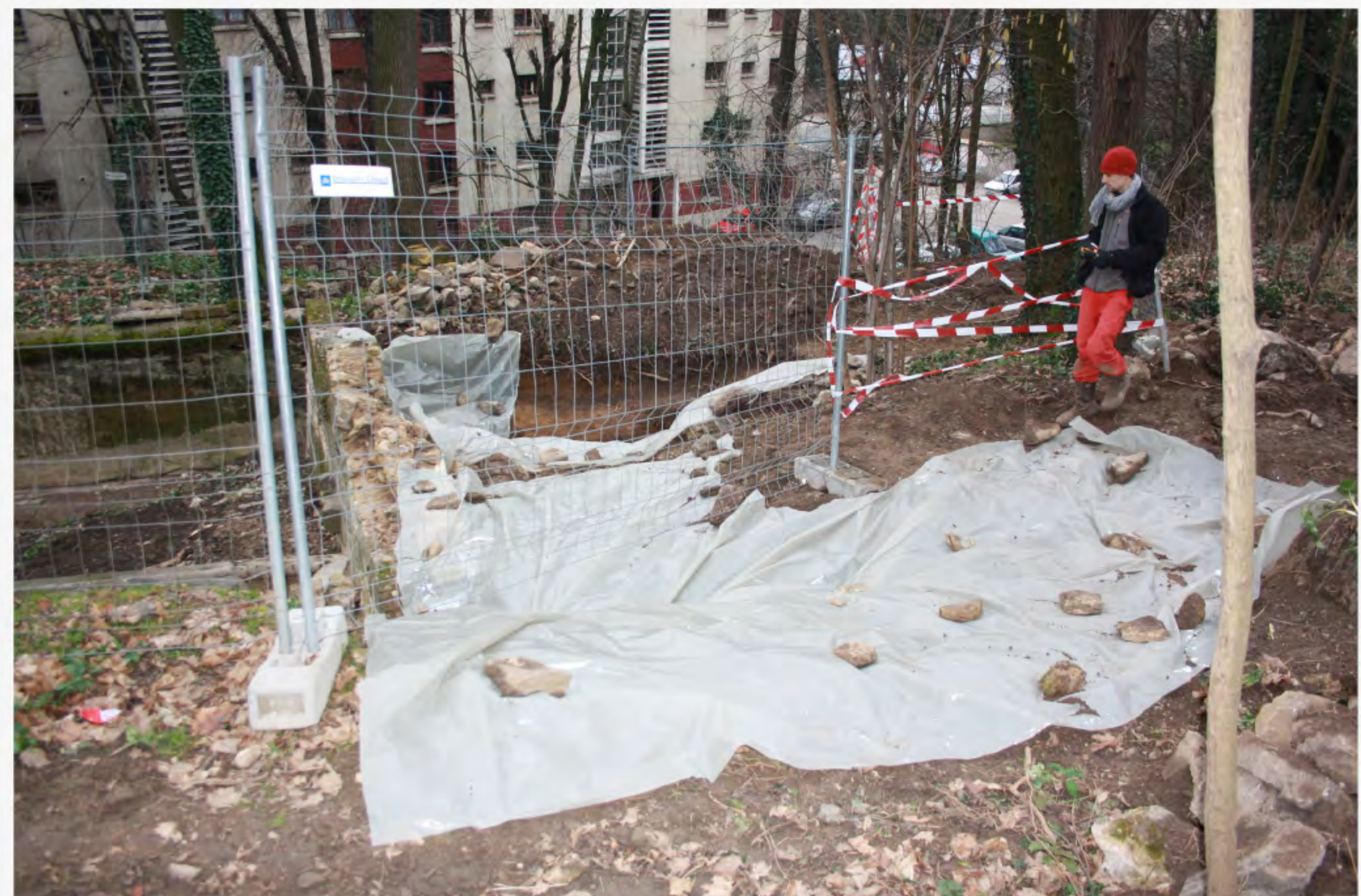
protection des vestiges par grand froid
