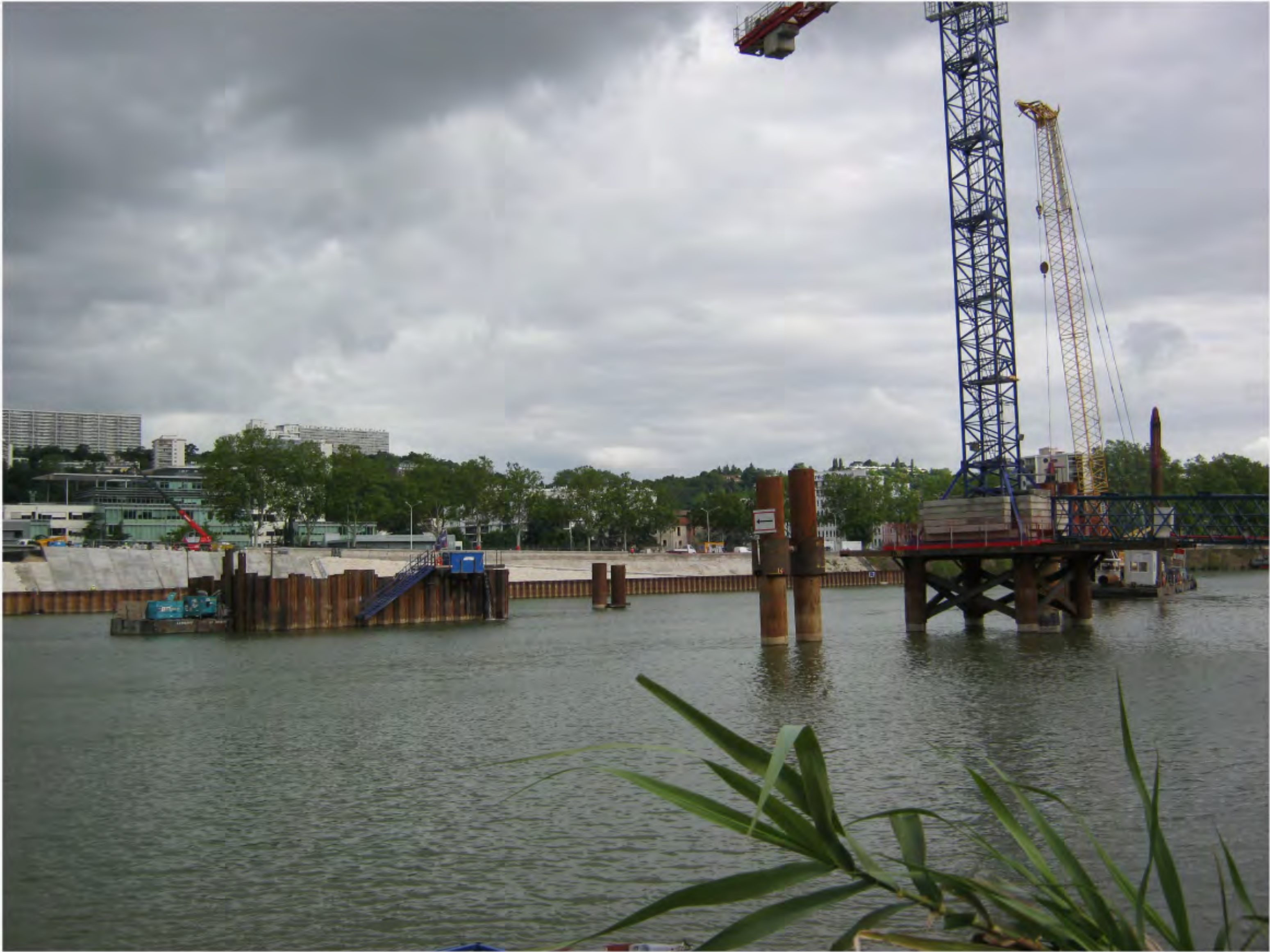
vue extérieure du batardeau sur la Saône
