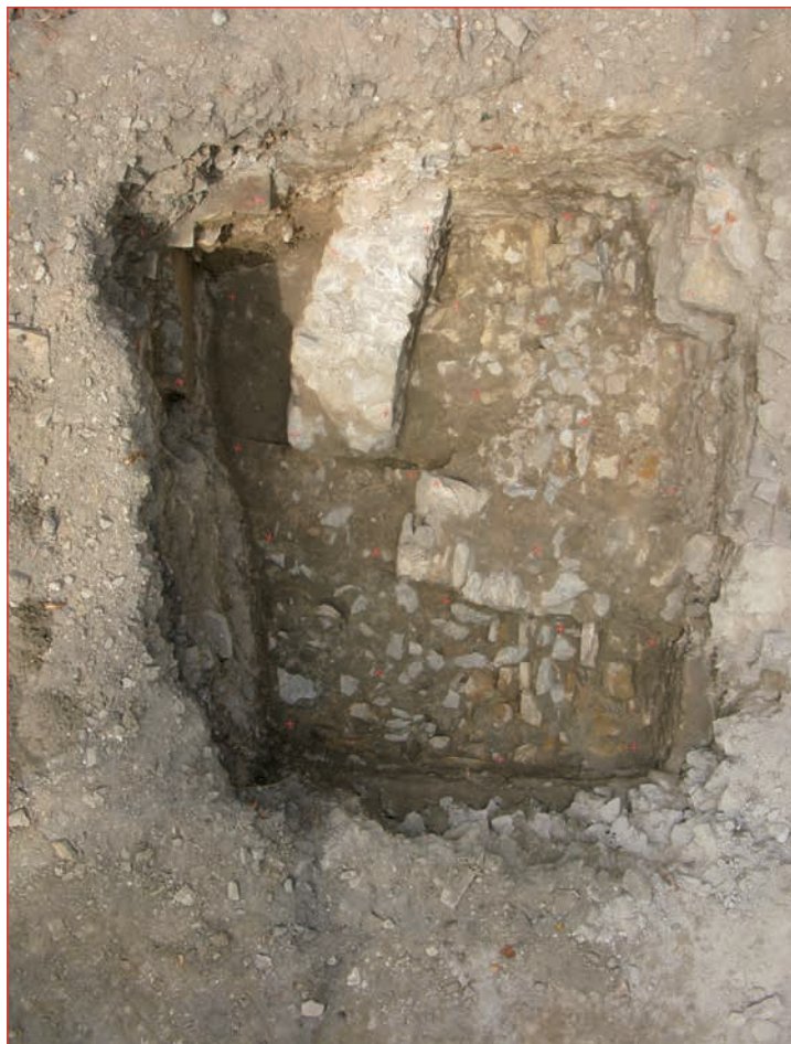
photo pour orthorectification : vue en plan de la maçonnerie de la galerie GA21 (phase 1)
