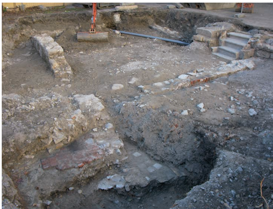
69389-2210431_030 : Vue générale du chantier depuis le nord-ouest.
