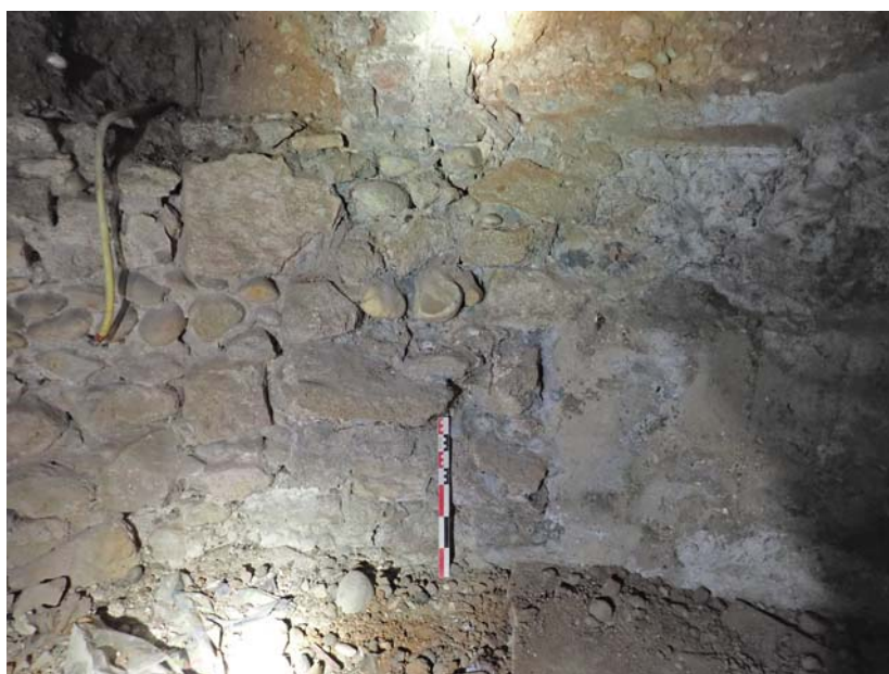
Vue de la même maçonnerie depuis l'intérieur du bâtiment
