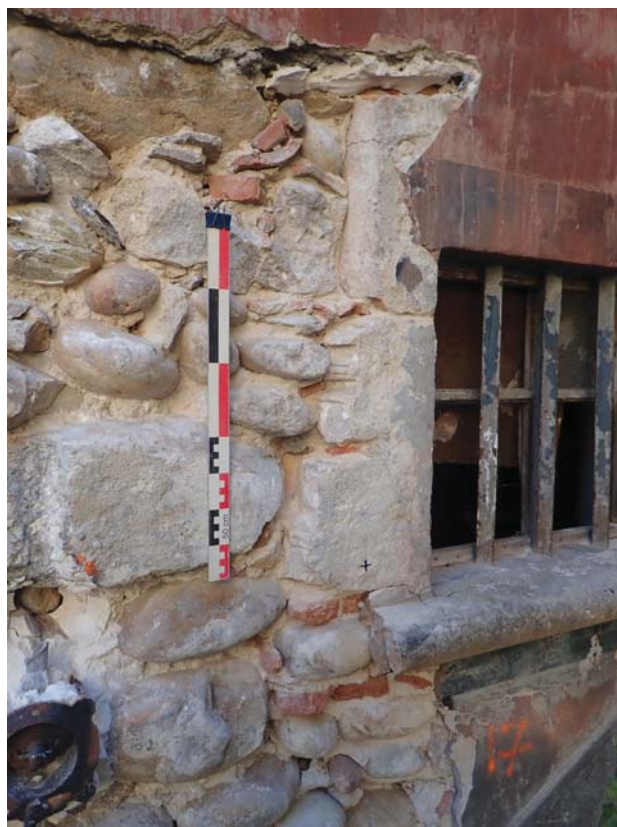
"La baie 734 est sous le piédroit en réemploi"
