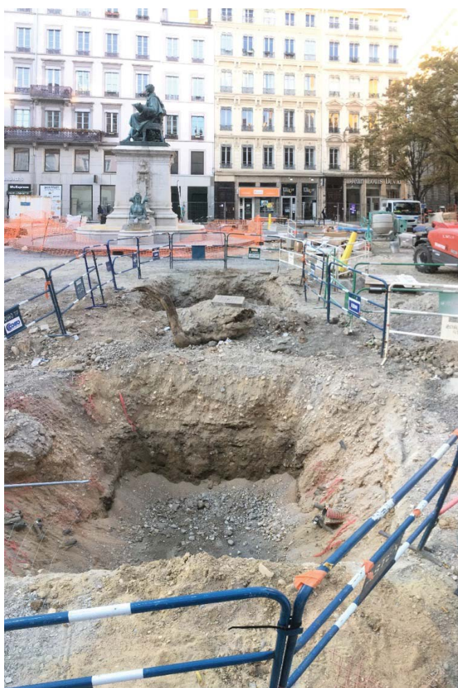
Fig. 4. Fosses de plantation au nord de la place Ampère
