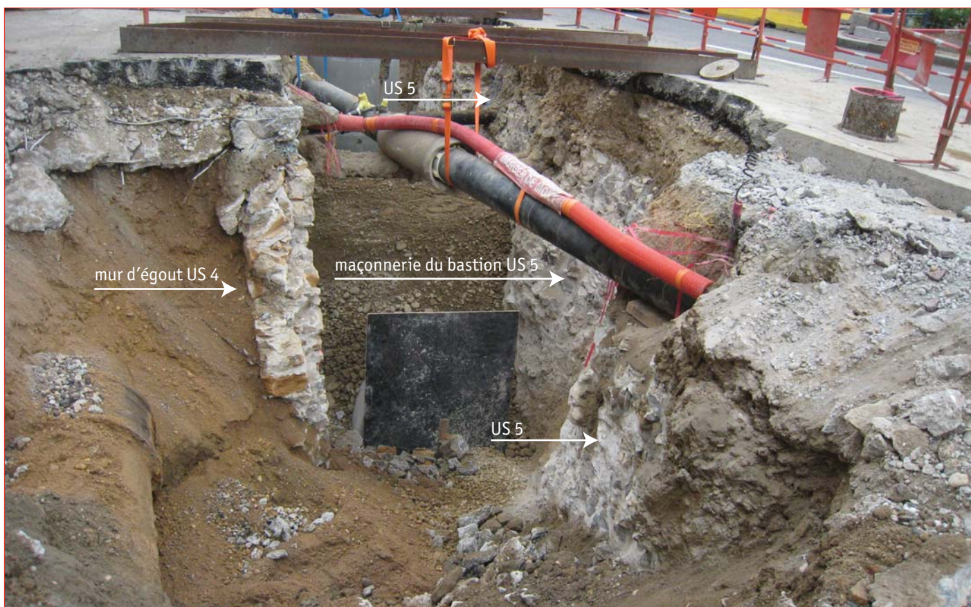
Vue générale de la maçonnerie US 5 depuis le sud
