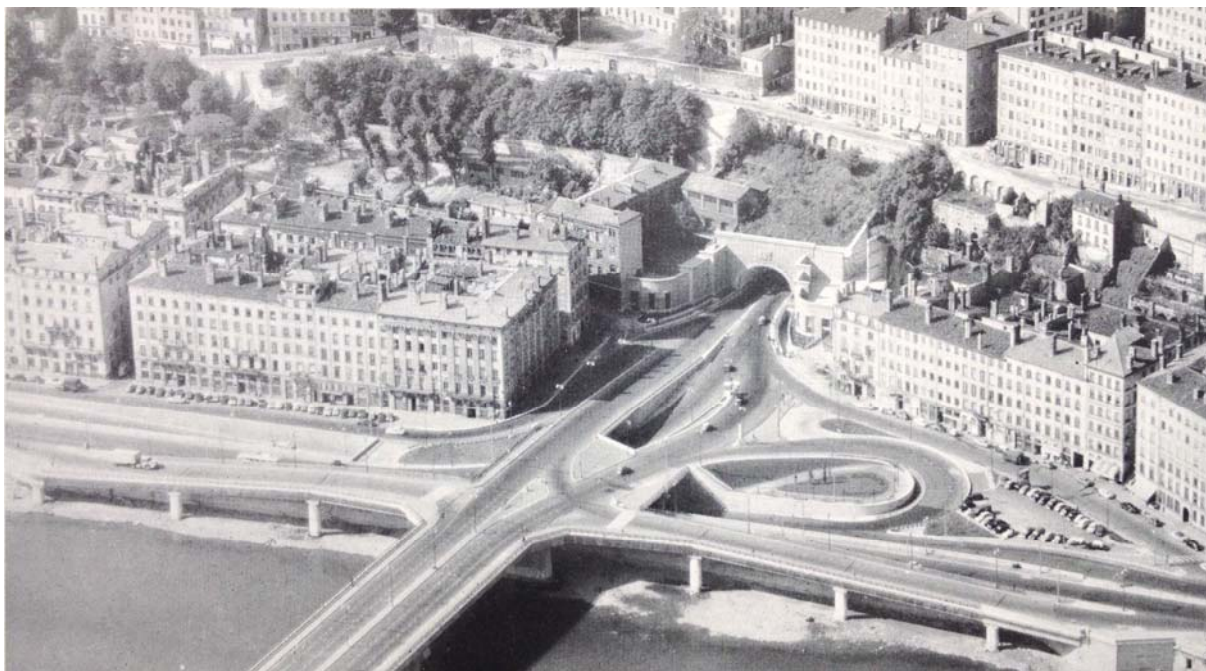
Fig. 9 : La place Chazette en 1960 (Arch. dép. Rhône, 2308 W 110)
