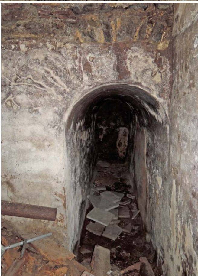
2. Couloir d'accès à l'hypogée ?
