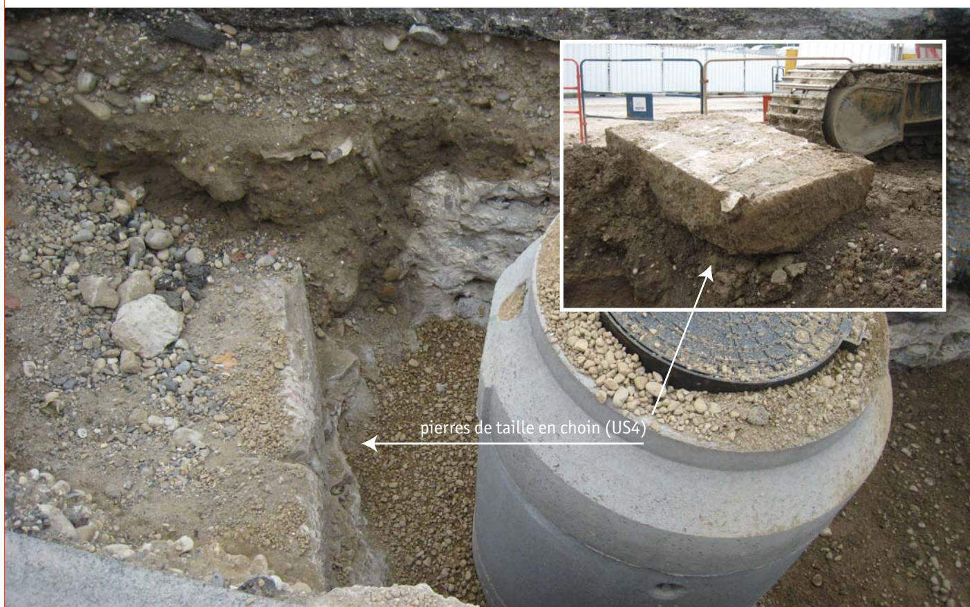
Maçonnerie de pierres de taille de choïn (US 4), orienté d'ouest en est, au nord du bastion
