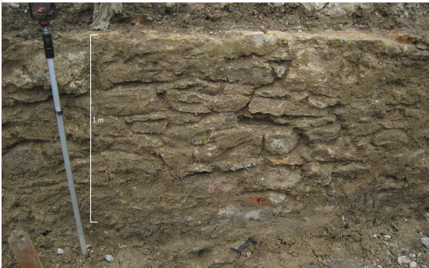
Vue de détail du parement est du mur US 1
