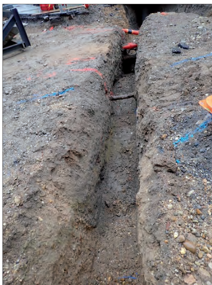
2. Vue rapprochée de la tranchée sud du sondage SD15 (vue depuis l'est)
