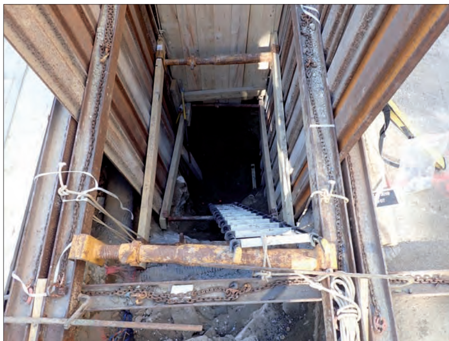
1. Vue générale des blindages du sondage SD13 (vue depuis le nord-est)
