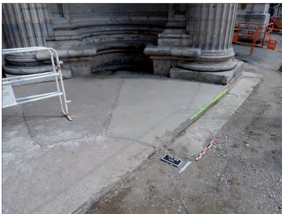
2. Vue des marches de l'US1403 installées après l'alignement des dalles du porche central sur les dèes des colonnes. La taille des dalles est peu soignée et contraste avec le porche nord (vue depuis le Nord-Ouest)
